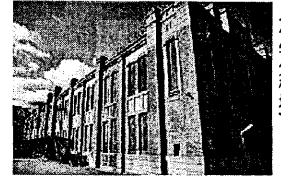
旧大阪砲兵工廠 (化学分析棟)
